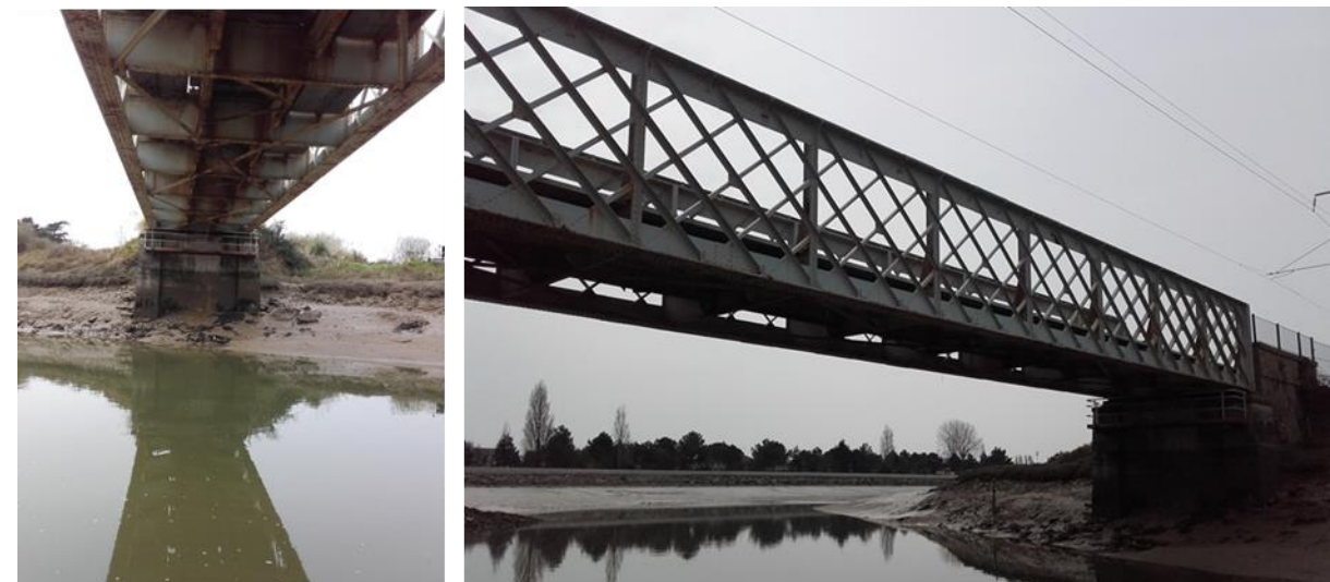
Ci-dessus le dessous du tablier avec sa poutraison, sur l'image de droite le treillis de poutre caractéristique de ce type d'ouvrage du XIXème siècle. (source iconographique SNCF 2017)
