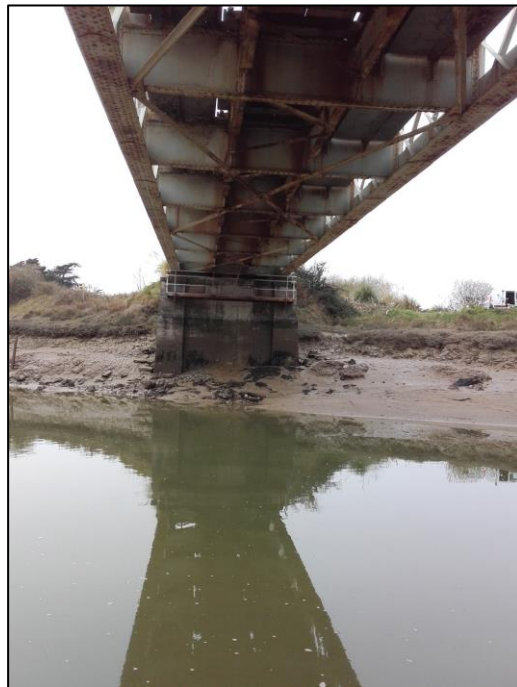
Figure 7 : Vue du dessous du tablier métallique
