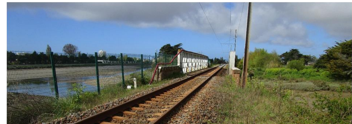
Ci-dessus trois photos de l'ouvrage (Source iconographique © SNCF, Les Ateliers UP+SCE)
