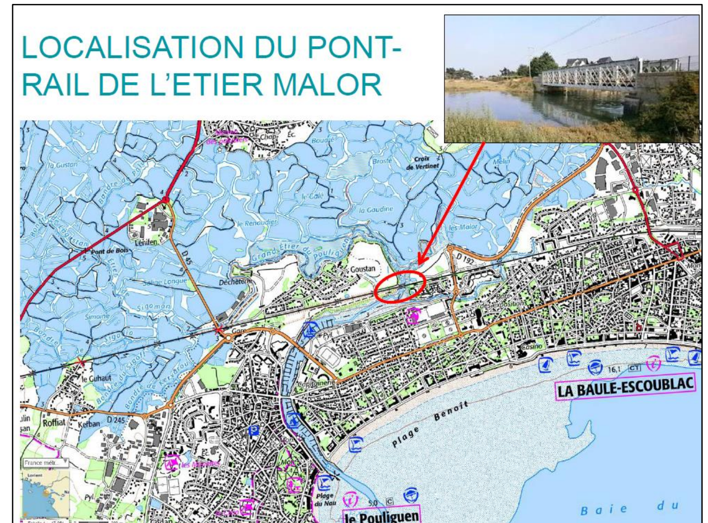
Figure 1 : Localisation du Pont-rail de l'Étier Malor
