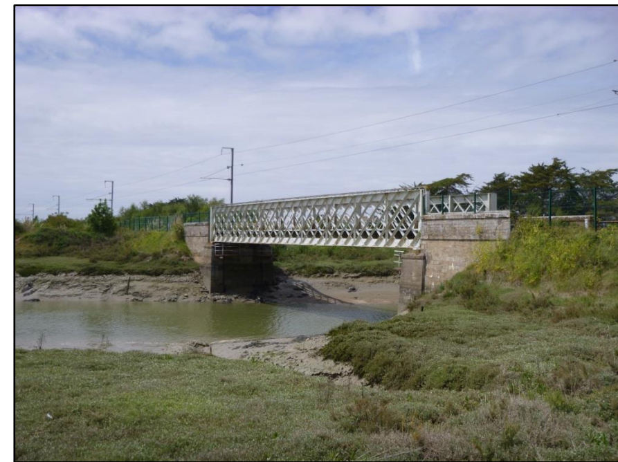
Figure 5 : Vue sur le tablier depuis la culée côté Le Croisic
