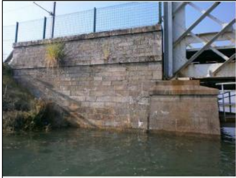
Figure 6 : Vue du chemisage en béton réalisé en 1964/1965
