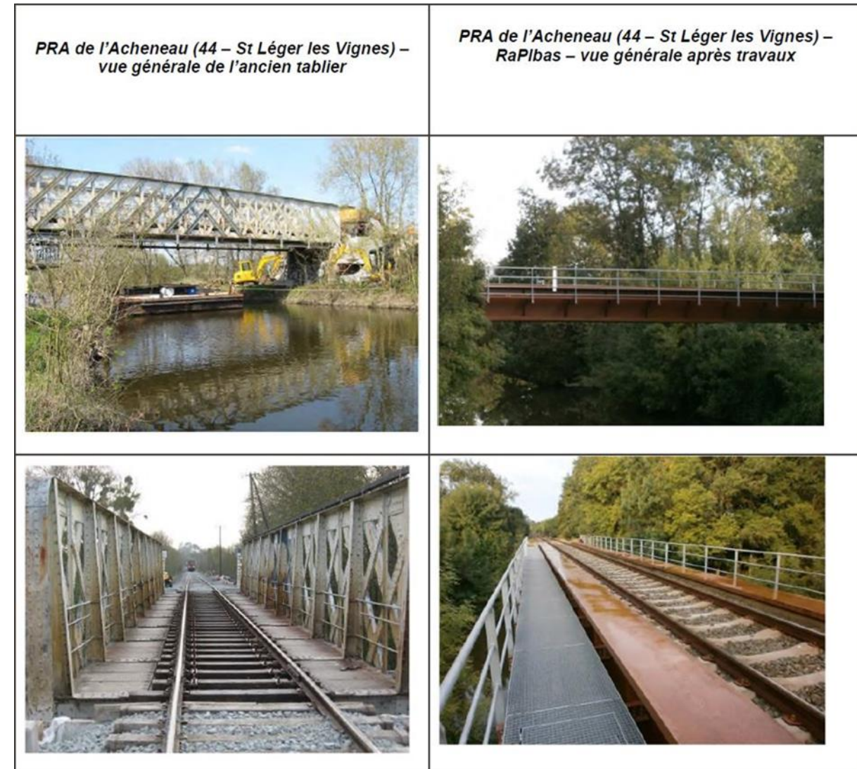
Pont rail franchissant l'Acheneau à Saint-Léger les Vignes (image SNCF)
