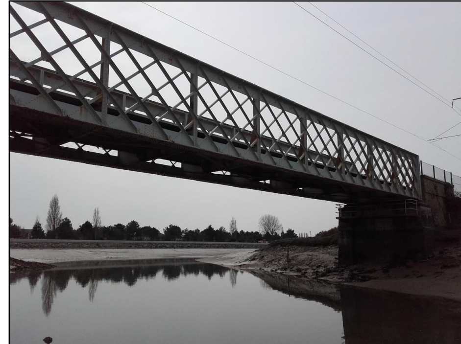
Figure 8 : Vue latérale de l'ouvrage avec ses poutres, côté Sud
